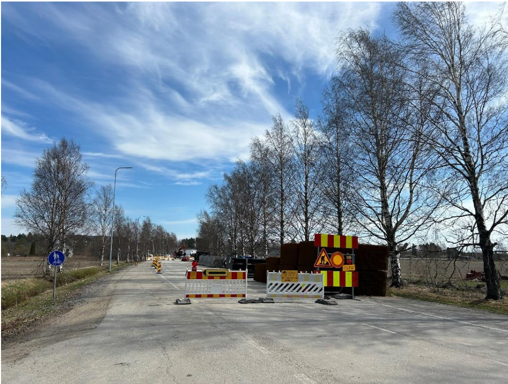
Bild 5. Björkraden längs Nybrovägen samt byggarbetsområde för Skarpängsvägen och en anslutande underfart fotograferade i april 2024.
