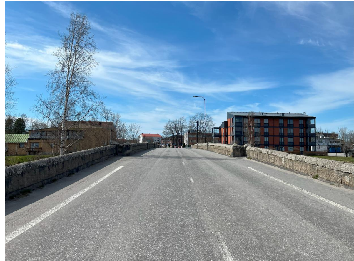
Sillan kansi nykytilassa, kuvattu sillalta keskustan suuntaan
