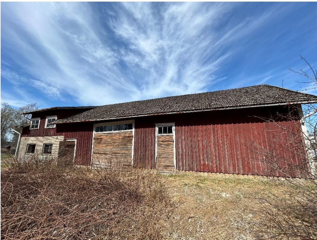
Kuva 12. Puretun omakotitalon pihapiirissä sijaitti myös talousrakennus. Molemmat rakennukset on sittemmin purettu.
